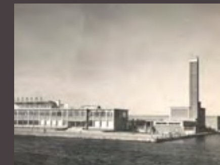
10. CABALLERO INNOVATIEFABRIEK, VOORHEEN LAURENS SIGARETTENFABRIEK 1953, verbouwing 2005 — adres: Saturnusstraat 50 architect: F. van der Togt en L. Huijds, verbouwing: GroupA Aukett
