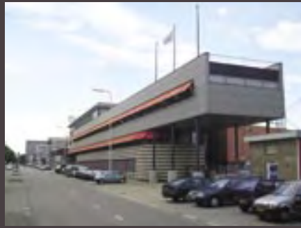
5. BEDRIJFSGEBOUW HTM INFRA 1992-1993 — adres: Maanweg 94 architect: Karel Nieuwland Architecten
