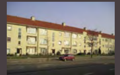
11. WONINGBOUW BINCKHORSTLAAN 1949 — adres: Binckhorstlaan architecten: J. Lucas en S. van Hoogstraten
